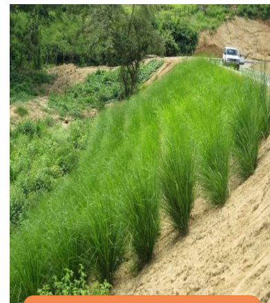
Estabilización De Taludes Con Pasto RETIVER
