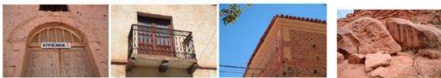
Figura 25. Material Constructivo de la viviendas en Camargo
