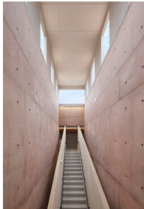
Paneles Prefabricados
