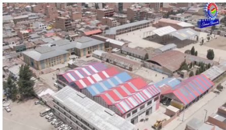
Coloraciones en Cubiertas
