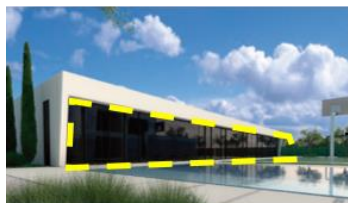
Los materiales utilizados para la construcción de estos prefabricados son básicamente paneles de cemento reforzado y vidrio.
