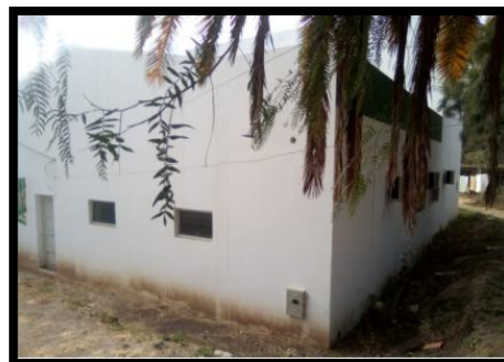
ILUSTRACIÓN 9: Instalación destinado para el aislamiento de pacientes infecciosos en el HRSJD
