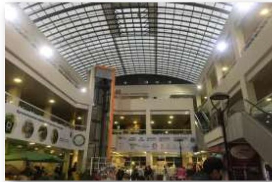
Cubierta de policarbonato en el patio central para el aprovechamiento de la luz natural
