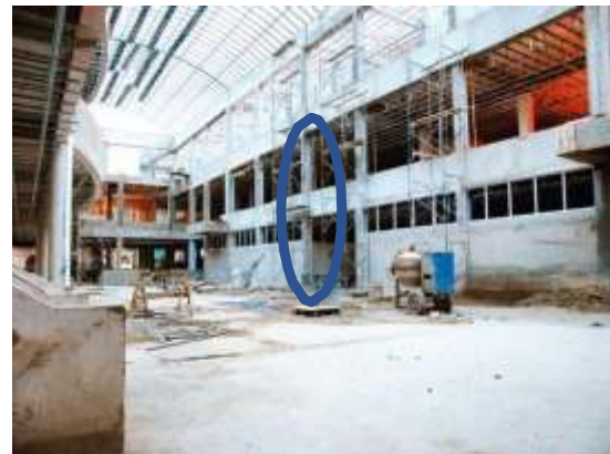
Columnas de hormigón armado
