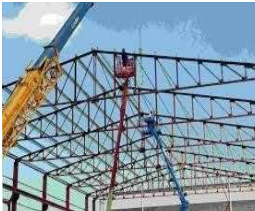
Estructura metálica con cerchas triangulares
