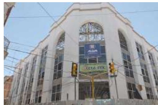
Acrilamiento para mejor iluminación y ventilación cruzada natural
