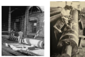
restauración del templo, tallado de columnas por pobladores
