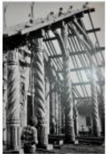
La Restauración en la construcción de la cubierta
