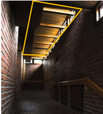
Figura 17: Uso de la madera en vigas
