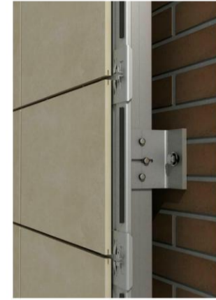
DETALLE DE LA FACHADA FALSA DE ALUCUBOND ESC:1:20
