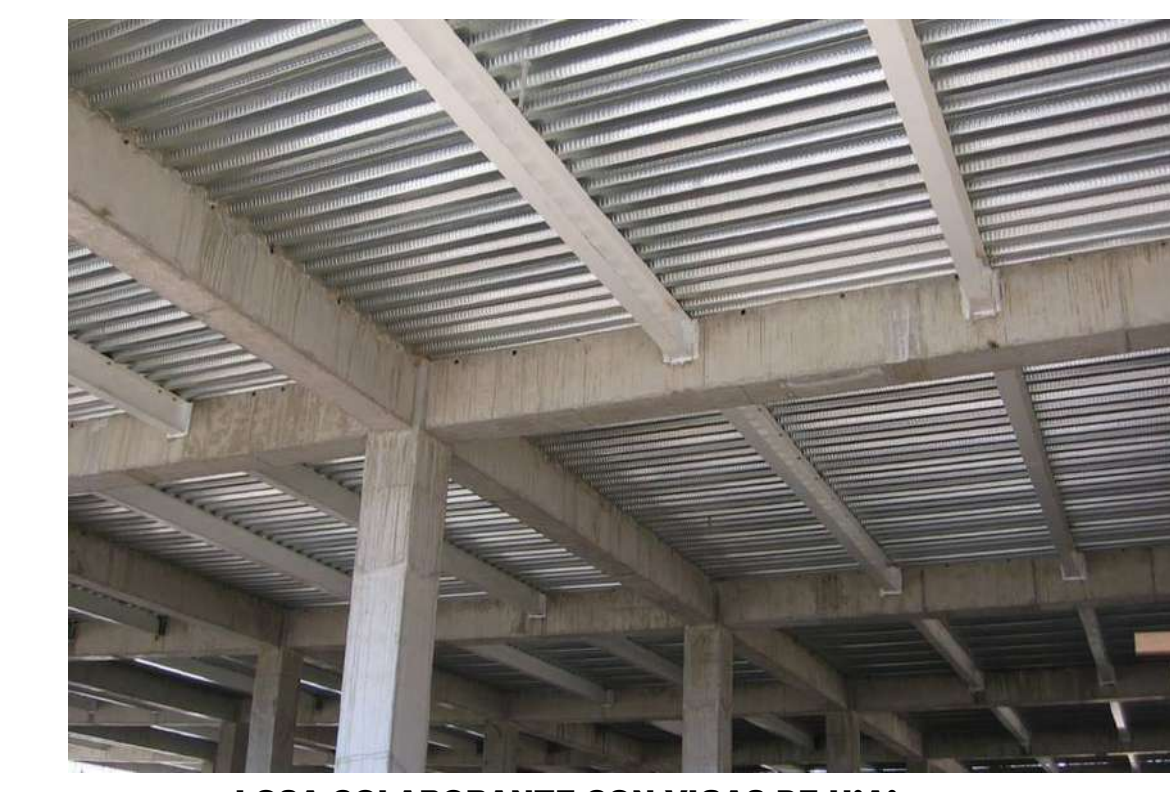
LOSA COLABORANTE CON VIGAS DE H^A
