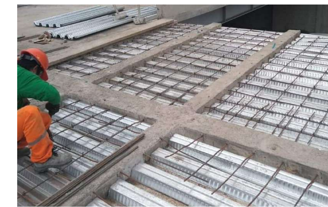
LOSA COLABORANTE CON VIGAS DE H^A^
