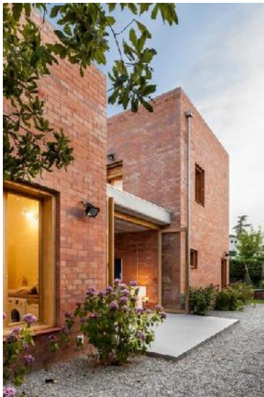
Ilustración 7.23. Fachada de ladrillo. Fuente: Plataforma arquitectura.
