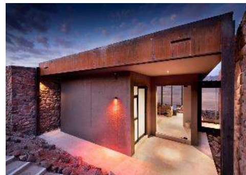
Figura 32. Losa de H° A°
