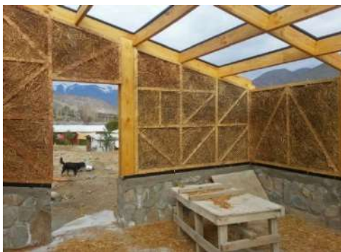
Figura 35. Estructura de madera
