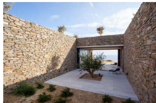
Figura 93. Muros de piedra
