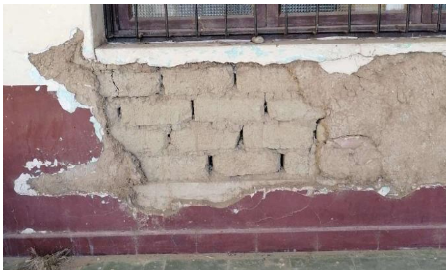
Ilustración 78 - Fotografía muro de adobe
