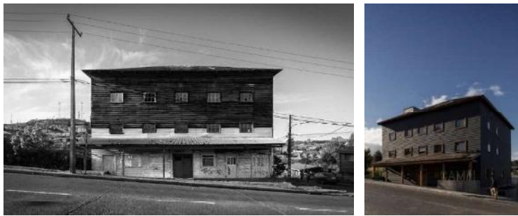
Ilustración 17 – Reciclaje de fachada en el Centro de Arte.
