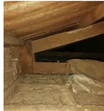
Ilustración 79 - Fotografía estructura de madera bloque A
