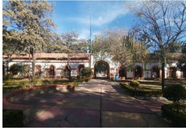
Ilustración 58 - Bloque Primario – Fachada Principal
