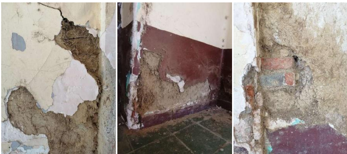
Ilustración 80 - Fotografías de revoque grueso y fino Bloque A
