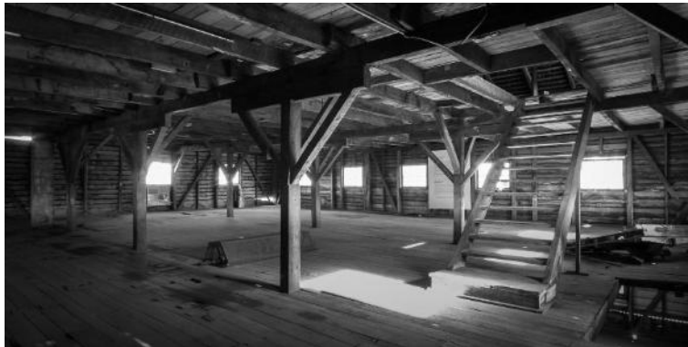
Ilustración 7 – Fotografía de vigas y pilares de madera del edificio.
