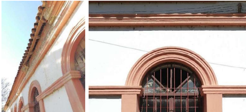
Ilustración 87 - Fotografía de aleros Bloque A
