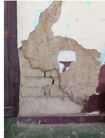
Ilustración 77 - Fotografía cimientos y sobrecimientos
