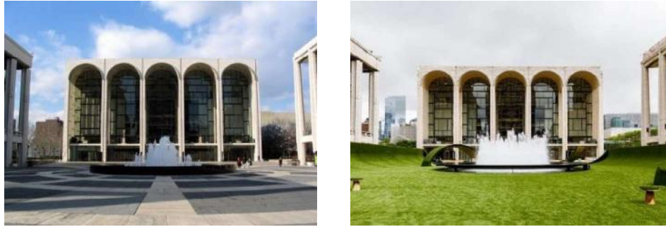
Ilustración 28 – Fotografías del antes y después de la intervención
