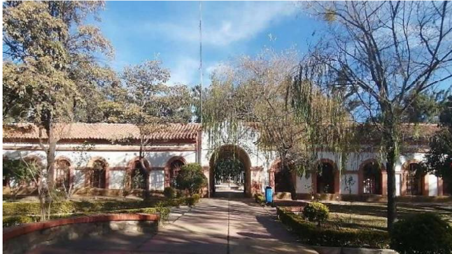
Ilustración 113 - Fachada del bloque a intervenir.
