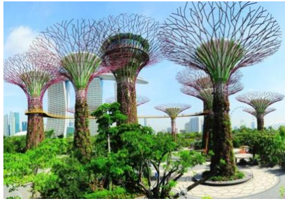
Imagen N° 111: Colectores de aguade lluvia
