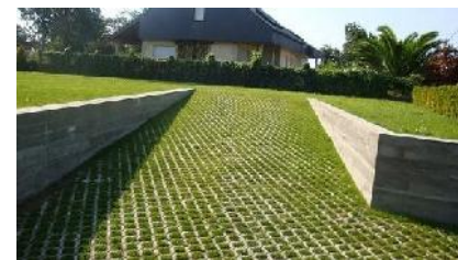
PISOS PERMEABLES QUE REDUCE LA RADIACION SOLAR
