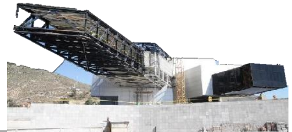
ESTRUCTURA METALICA PARA VOLADIZOS
