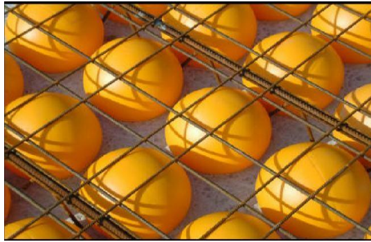
Figura 2.18. Esferas de polietileno de alta densidad. [5]
