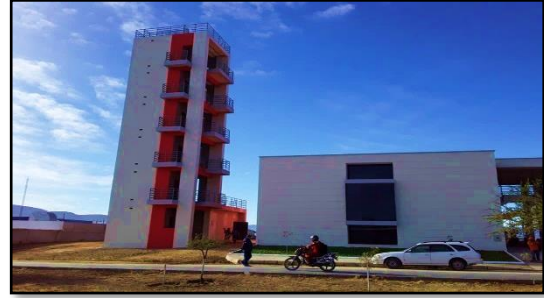
Figura 14: Cuartel de Bomberos en Tarija, fachada lateral
