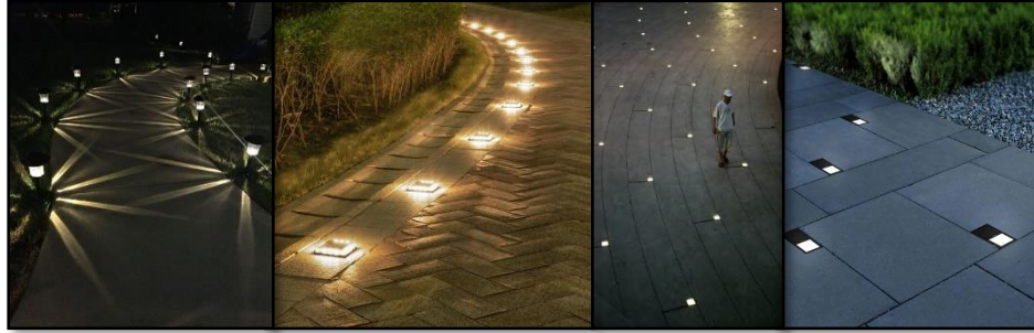
Figura 134: Luces Led en pisos
