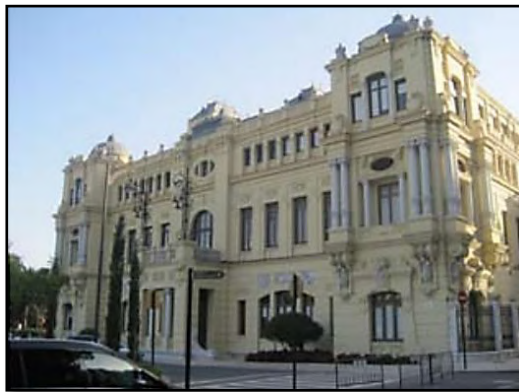
Figura 19: Uno de los primeros edificios administrativos. Ayuntamiento en Málaga
