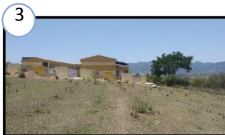
3.- Vista al sur casa de la mujer prov. O'Connor
