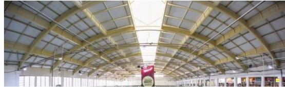
La implementación de vigas de hormigón en arcos de medio punto ayudados con tensores de hierro. A la vez estas van apoyadas en pilares de H° A°.
