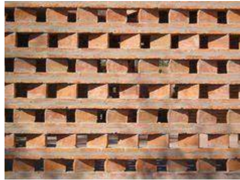
Figura 76. Aparejo de Ladrillo Gambote
