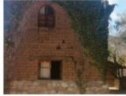
Muros de tierra
