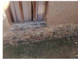
Basamento de piedra
