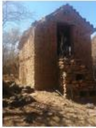
Cubierta de teja con dos caídas
