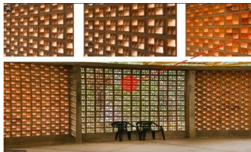
Imagen N° 76: Muros de Cerramiento, Centro El Rodeo Fuente: https://www.plataformaarquitectura
