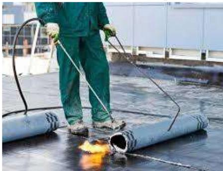
**3.1.5.** Luego se coloca el segundo rollo con igual técnica que para la anterior, traslapándola al primero entre 8 y 10 cm. En terrazas se deberá subir en los zócalos a una altura mínima de 10 a 20 cm.
