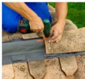
Ganchos de fijación de las tejas de caballete en la cumbrera
