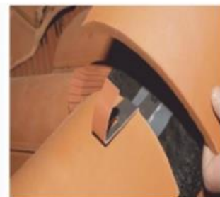
Ganchos de fijación de las tejas de caballete en la cumbrera
