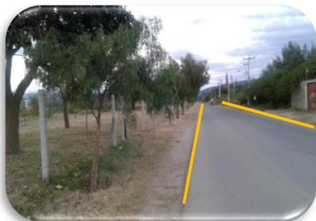
Imagen # 38Vía de tercer orden (elaboración propia)
