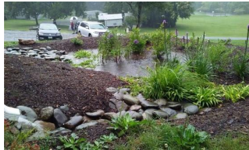
FIGURA 91 Ejemplo existente de biorretencion
