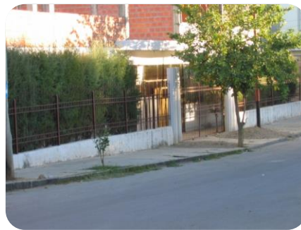
FIGURA 75 Cerramiento de viviendas
