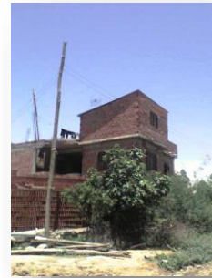
FIGURA 72 Vivienda en proceso de construcción
