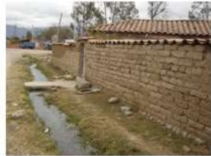
Vista exterior de la vivienda
