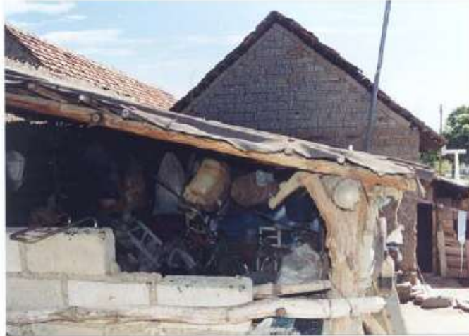
Vista del depósito
