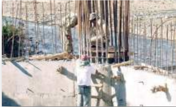
Figura 20. Obreros trabajando en el puente Bicentenario
