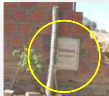
Figura 76. Gas domiciliario en distrito 9
