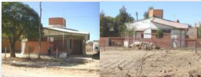
Figura 90. Puestos policiales en Distrito 9
