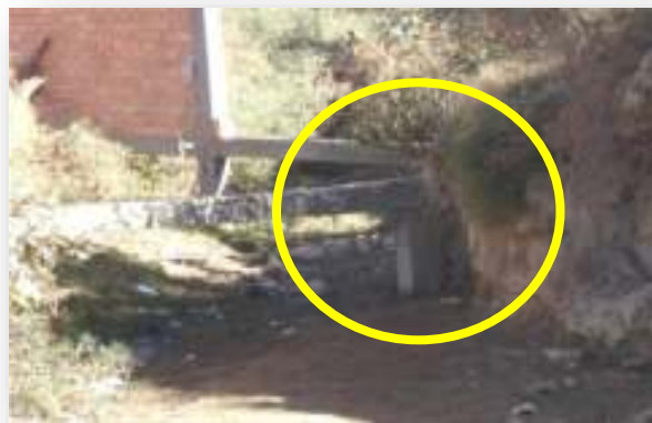
Figura 23. Construcción sobre quebrada, cimentaciones en plena quebrada
