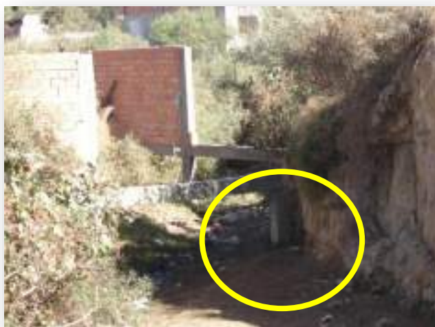
Figura 97. Construcción de vivienda sobre quebrada en Distrito 9
