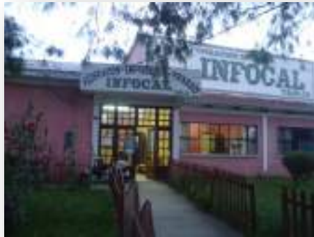
Figura 59. Fachada principal I.T.C. Infocal
