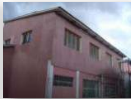
Figura 60. Fachada lateral I.T.C. Infocal
