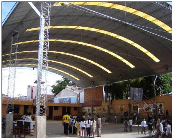
Vista desde el interior del colegio
