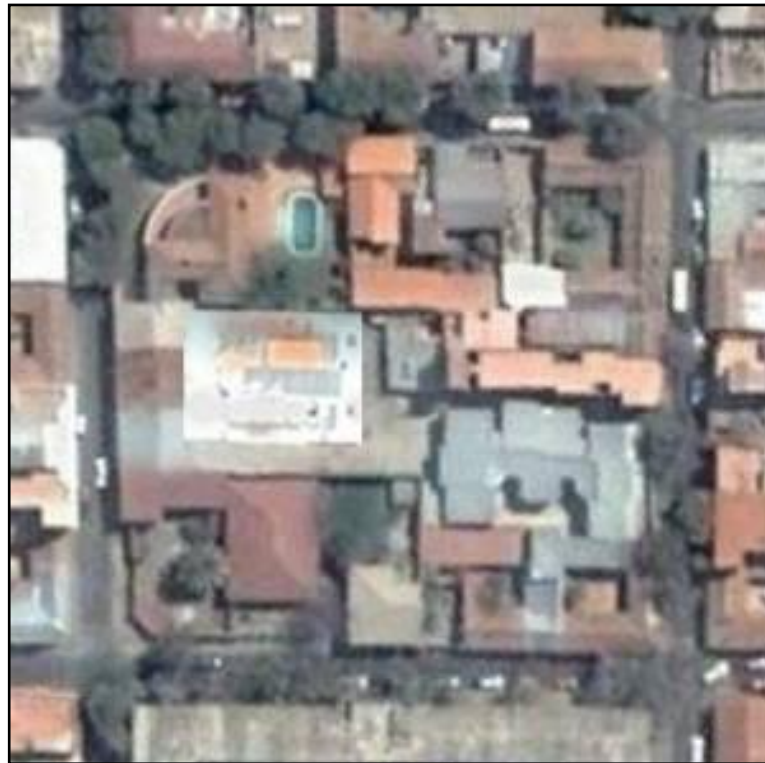
Vista área del colegio y su entorno.
