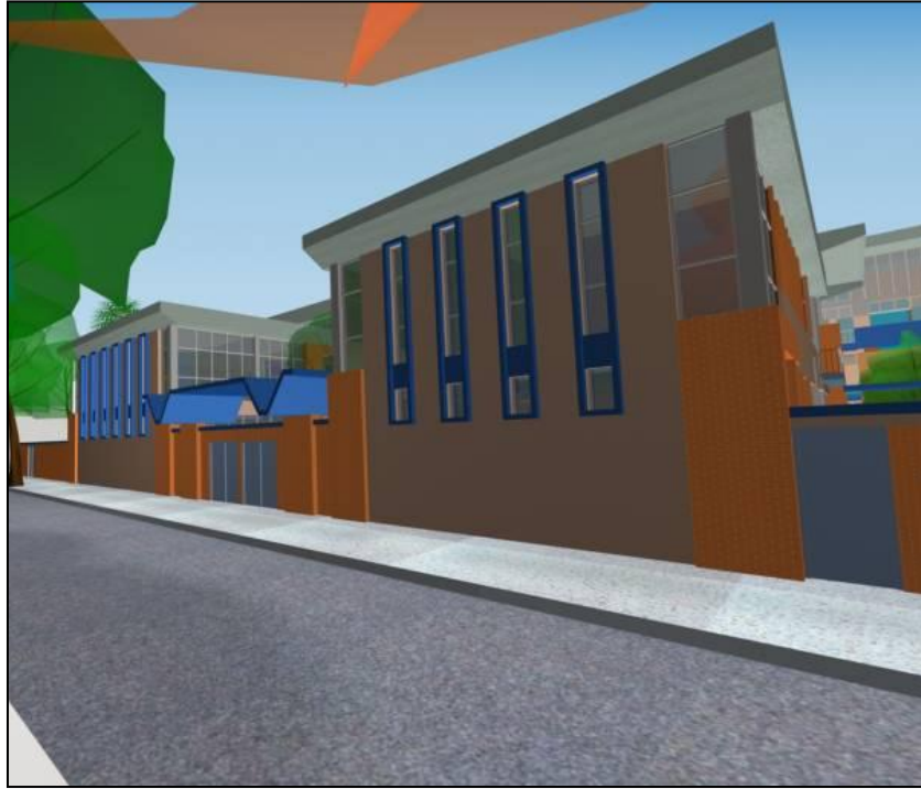
En las fachadas se aprecia la utilización del ladrillo y el hormigón para integrarse con las construcciones del entorno.
