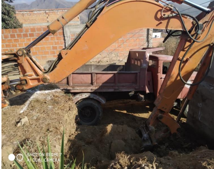
Movimiento de tierra con maquinaria
