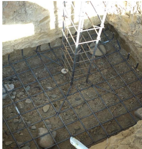
Vista de zapata posicionada según replante y arranque de columna
