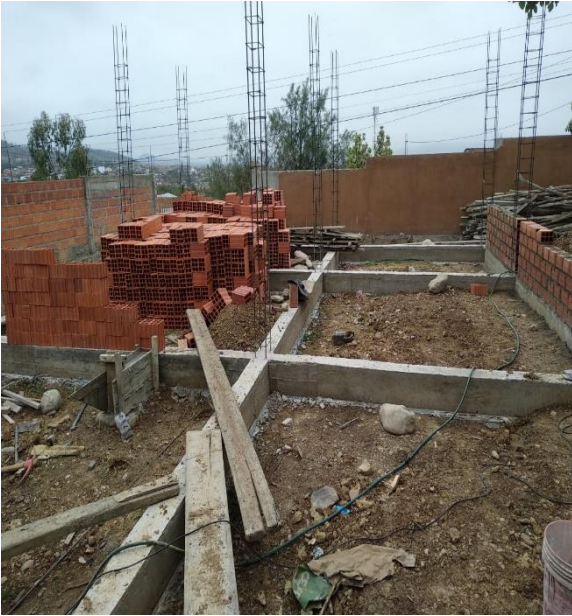
Ejecución de muros de ladrillo 6 h.
