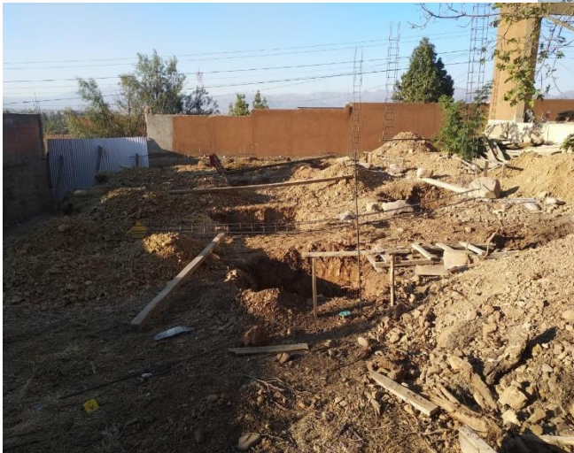
Zapatas excavadas con maquinaria
