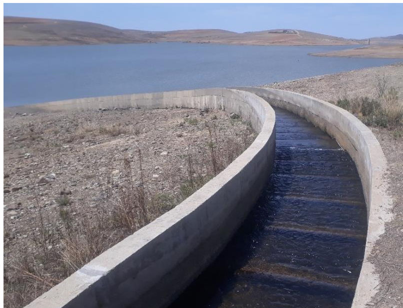
Figura 2.21. Canal de trasvase curva antes del vertedero escalonado de Huacata.
