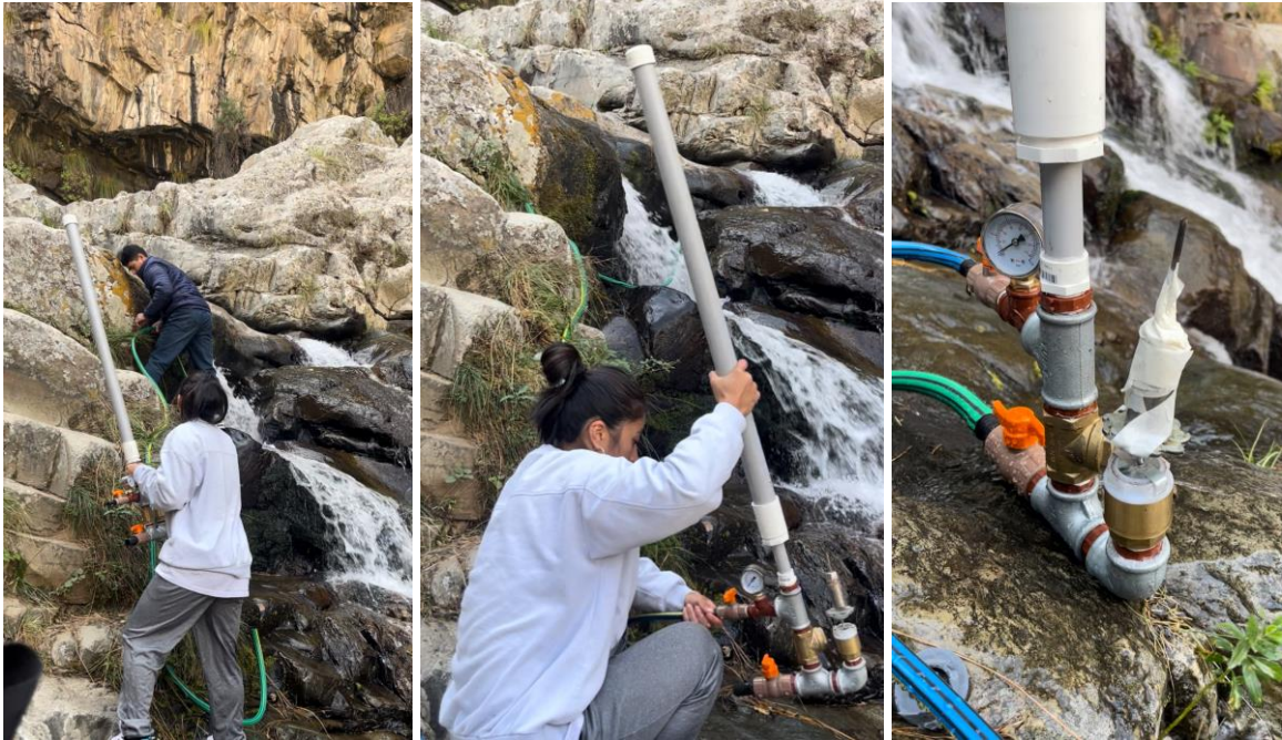
Figura N° 11. Ajustes previos al funcionamiento del prototipo. Fuente: Propia.
