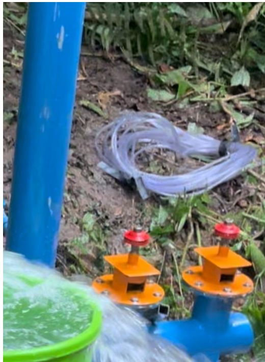
Figura N° 3. Medición de la altura de suministro con nivel de manguera. Fuente: Elaboración propia.
