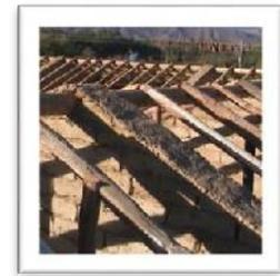
Las estructuras que se pueden ver varían de las construcciones más simples (viga central, sistema secundario que soporta la capa de cañas) hasta las más complejas, que cuentan con llaves en las vigas transversales aparentes y una estructura en forma de cruz que aguanta el caballete. Están consolidadas en muchos casos mediante un tirante horizontal.
