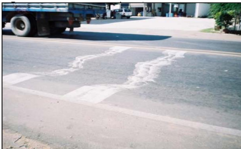
Figura 20: Ahuellamiento
