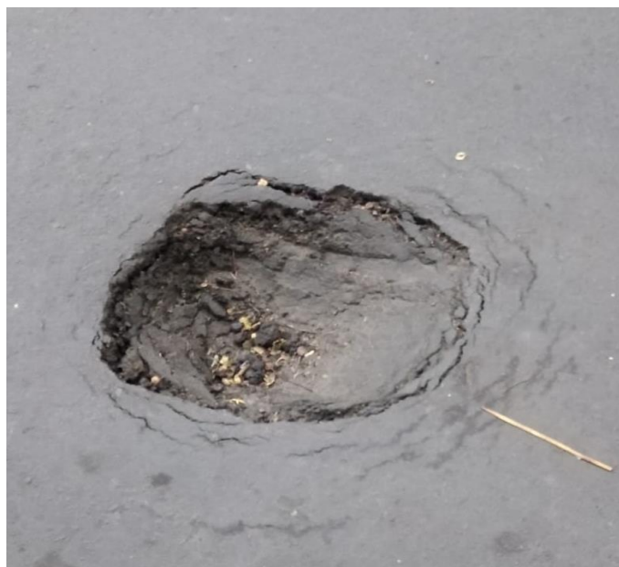
Figura 11: Abultamientos y hundimientos
