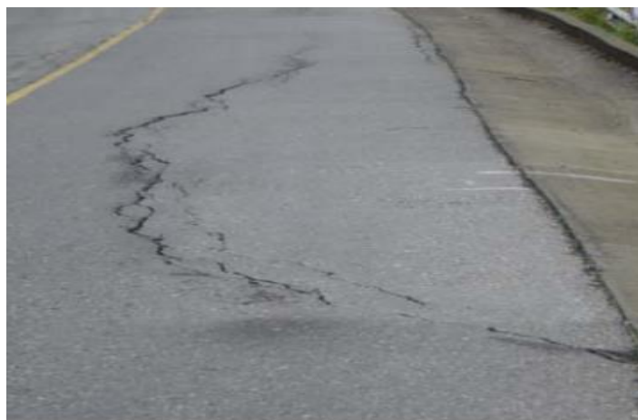
Figura 21: Fisura parabólica
