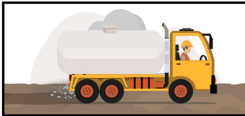
Figura 22. Aplicación de agua en la mezcla suelo – cemento del pavimento unicapa.
