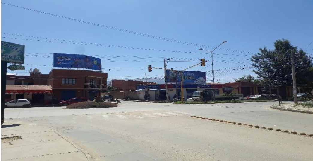
Figura 3.43. Señalización horizontal en la av. Circunvalación y sus intersecciones
