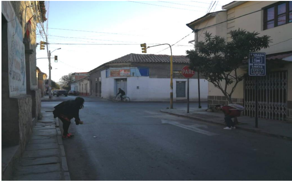
Figura 3.41. Señalización horizontal en la calle Cochabamba y sus intersecciones
