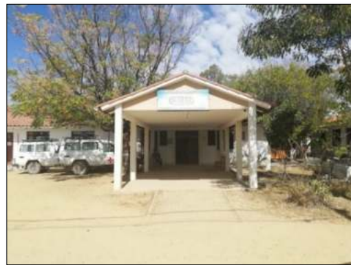
Figura 43: Centro de Salud FUENTE: Elaboración Propia
