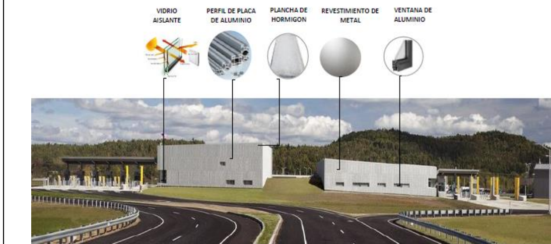
Gráfico 19. Modelo Real. Análisis. Puerto de entrada comercial y estación fronteriza E.E.U.U. – Canadá
