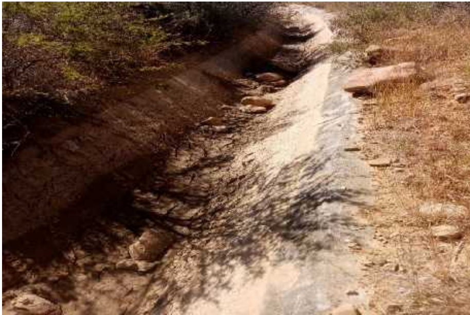
Figura 102. Canal Trapezoidal Trasvase sedimentado en la progresiva 7+440,10 a 8+408,050 (Muestra N°8).
