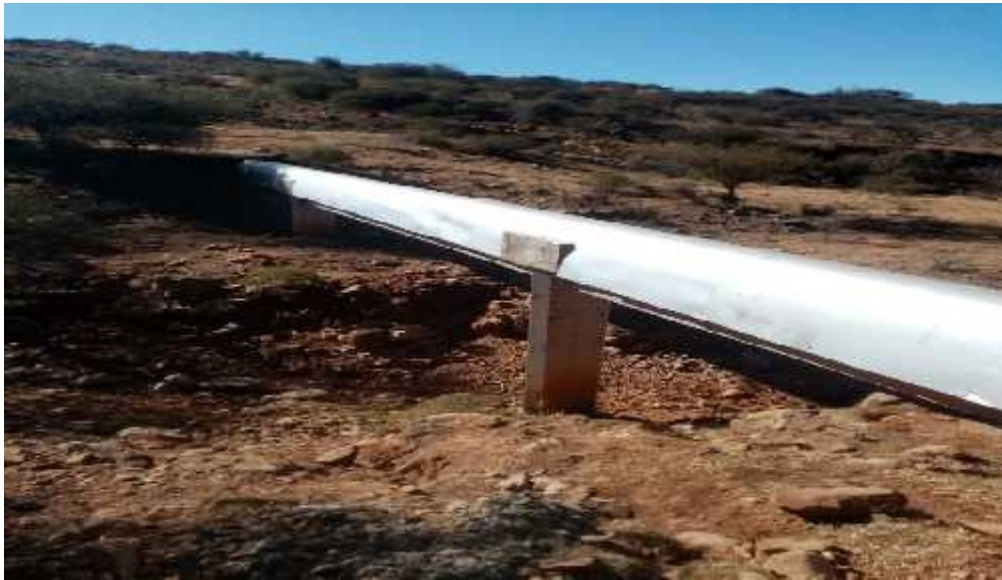
Figura 23. Puente paso de quebrada tipo del canal de trasvase.
