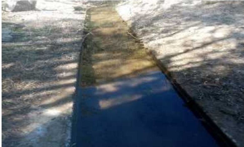
Figura 41. Sedimentos del canal de riego Tárraga progresiva 0+250 (Muestra N° 3).
