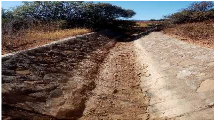
Figura 96. Canal de Trasvase con sedimento progresiva 7+148 a 7+262,45 (Muestra N°7).
