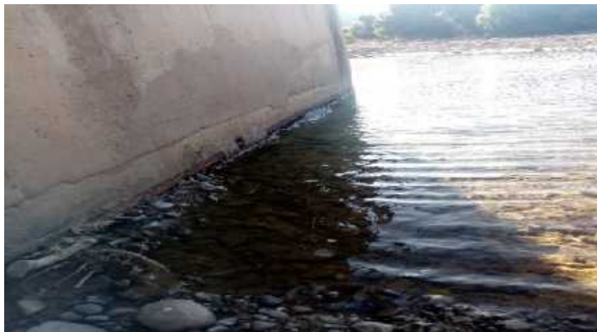
Figura 48. Bocatoma del sistema de trasvase (vista exterior).
