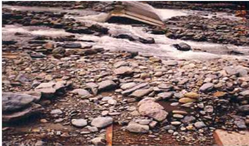
Figura 8. Sedimentos en obra de toma.
