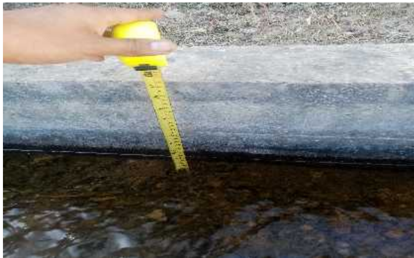
Figura 32. Medición de sedimentos del canal Tárraga progresiva 0+000 (Muestra N°1).
