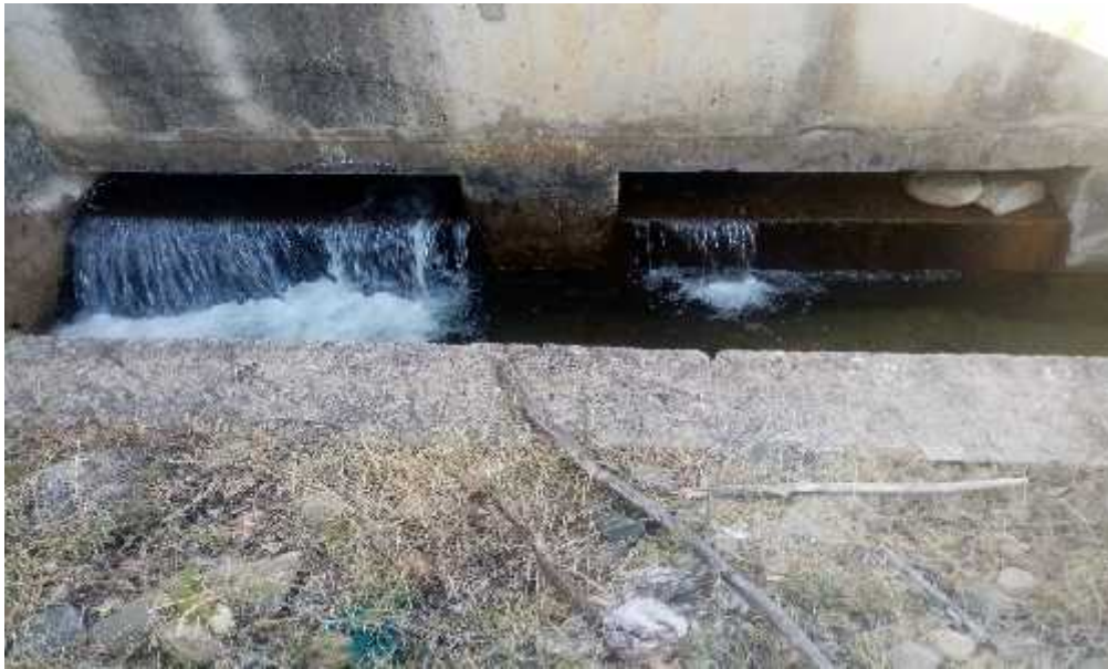
Figura 16. Bocatoma en muro lateral del sistema de trasvase.
