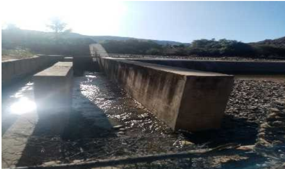
Figura 50. Despedrador canal de trasvase progresiva 0+000.
