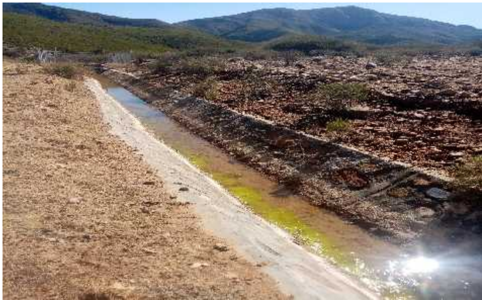
Figura 97. Canal trapezoidal de trasvase con sedimento en progresivas 7+148 a 7+262,45.
