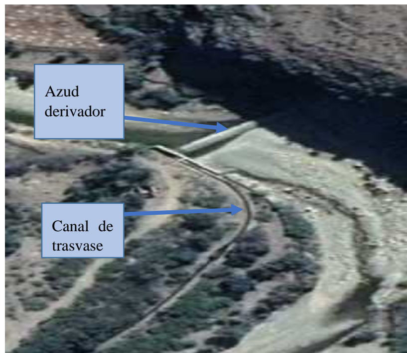
Figura 13. Vista satelital de la obra de toma del río Yesera de la Presa Calderas.
