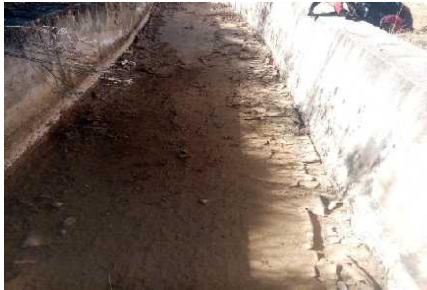
Figura 107. Canal de trasvase sedimentado prog. 8+408,050 a 8+534,70 (Muestra N°9).
