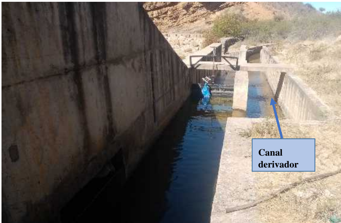
Figura 20. Canal derivador del sistema de trasvase.
