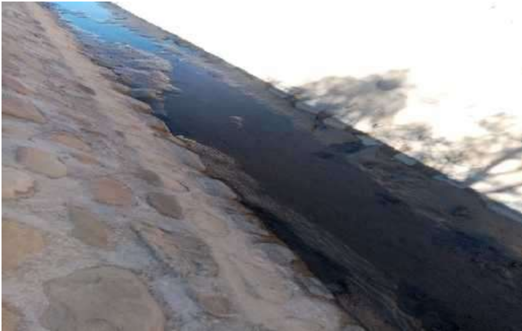
Figura 74. Sedimento en el canal de trasvase progresiva 3+180 a 3+779,95 (Muestra N° 4).
