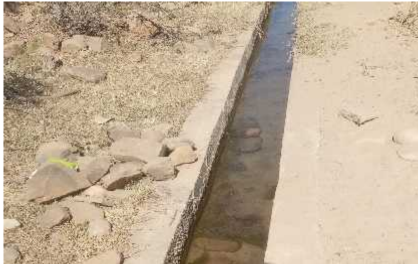
Figura 47. Sedimentos del canal Tárraga progresiva 0+400 a 0+501,11 (Muestra N°5).
