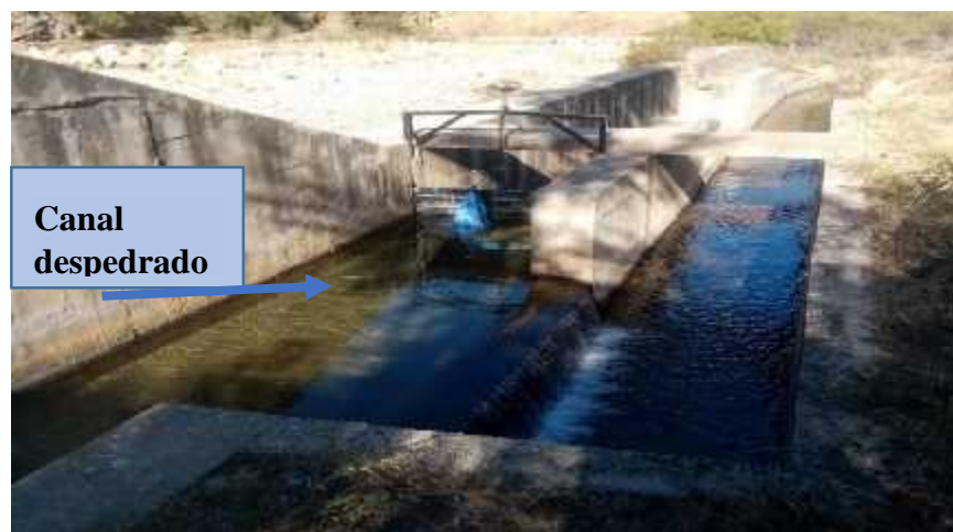
Figura 18. Canal despedrador del sistema de trasvase.
