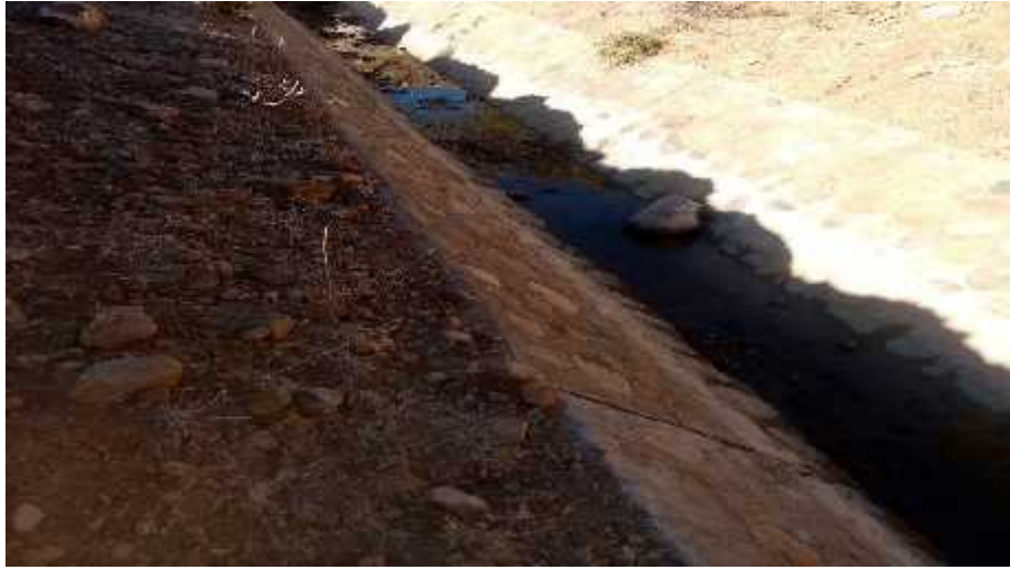
Figura 75. Canal de trasvase con sedimento grueso progresiva 3+180 a 3+779,95.
