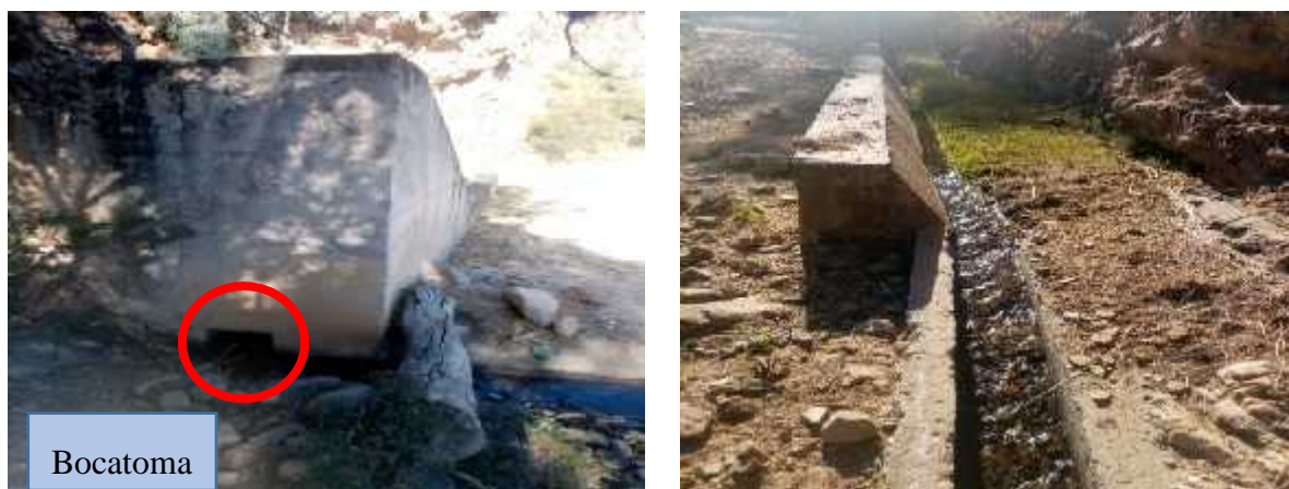
Figura 30. Entrada del canal de riego Tárraga por el muro izquierdo del azud.
