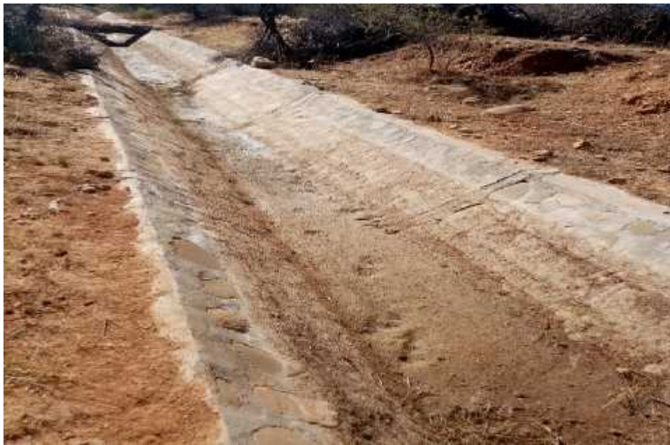
Figura 89. Sedimentos en el canal de trasvase progresiva 5+860 a 6+738 (Muestra N°6).
