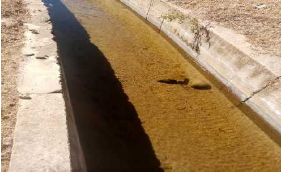
Figura 63. Canal de Traslase progresiva 1+000.
