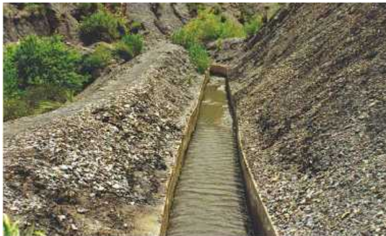
Figura 9. Conformación de bermas.
