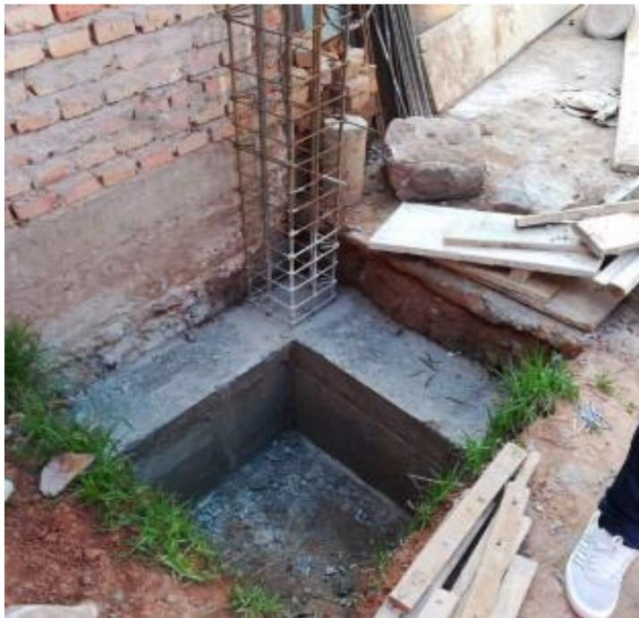
**Figura 70: Proceso de construcción de zapata con pedestal**
