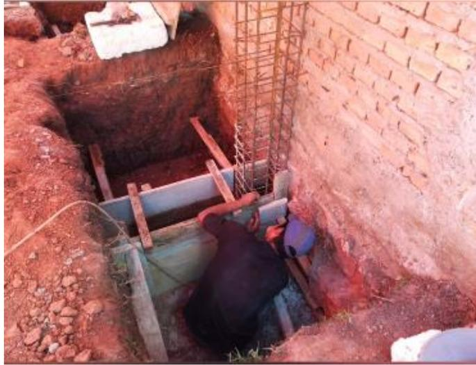
**Figura 68: Proceso de construcción de zapata con pedestal**
