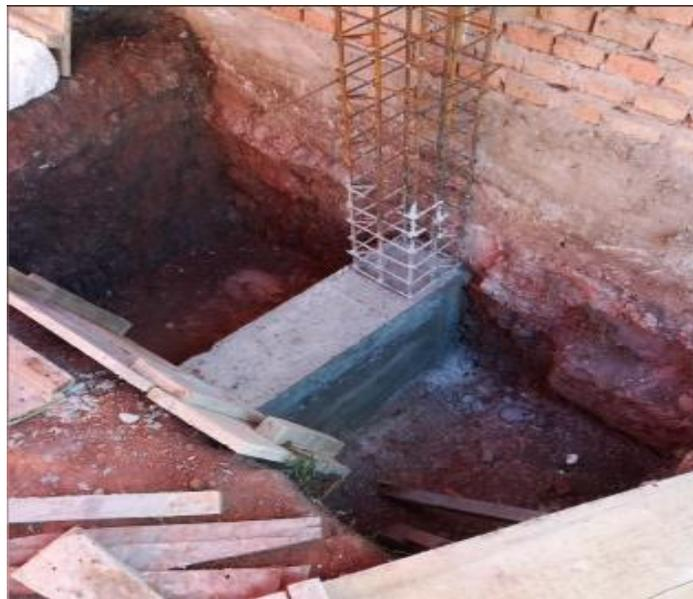
**Figura 69: Proceso de construcción de zapata con pedestal**
