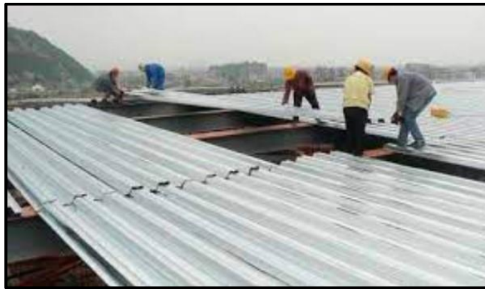
Figura 4.3 Colocación de placa colaborante
