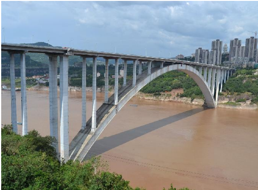
Puente en Arco de Tablero Superior
