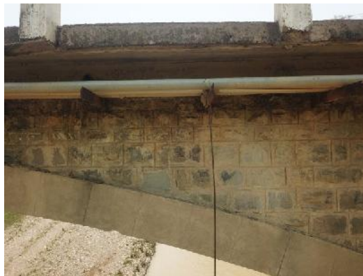
Mampostería del puente de Tomatitas
