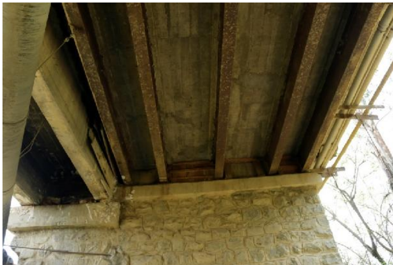
Vigas de Acero puente de Tomatitas
