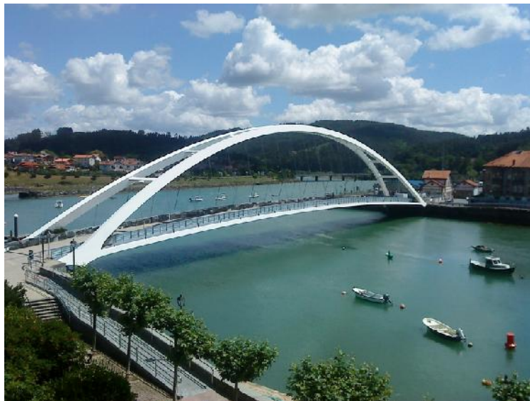
Puente en Arco de Tablero Inferior
