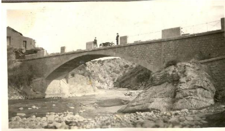
Puente Bóveda de Tomatitas 1928
