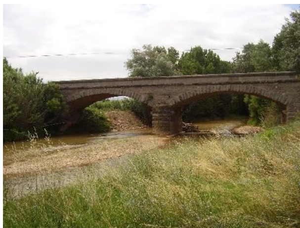
Puente Bóveda Tablero Superior
