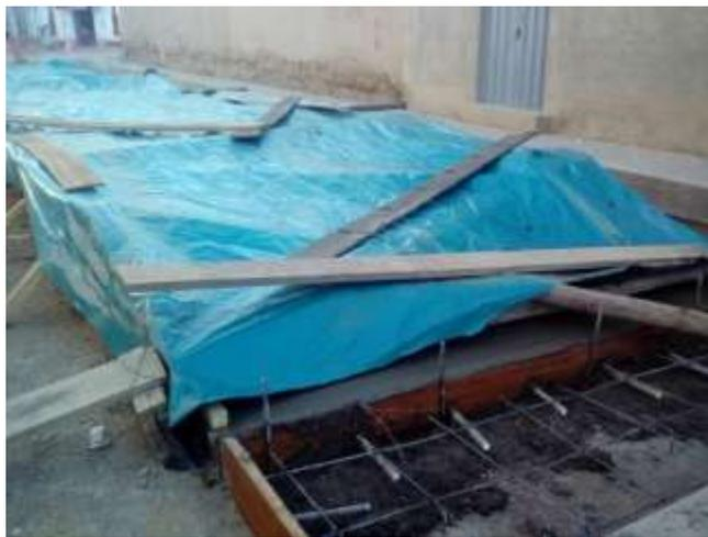
*Figura 2.4: Protección del Hormigón en Obra.*
