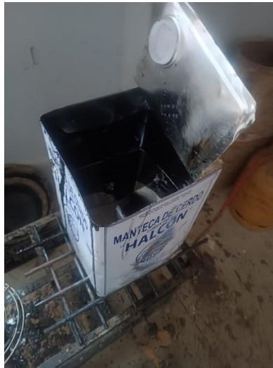
Figura 3.19 Calentamiento el cemento asfáltico
