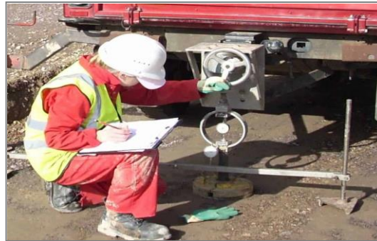
Figura 2.27 Instalación típica del ensayo en el terreno
