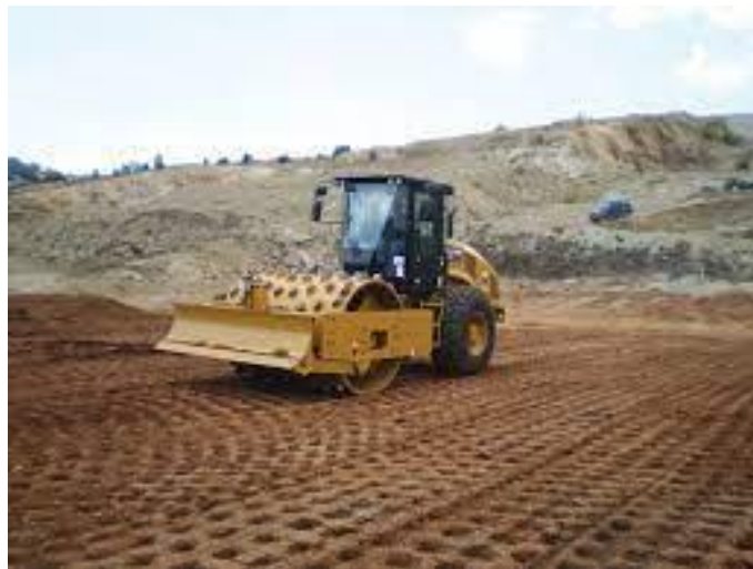
Figura 2.13 Técnica de compactación en obra
