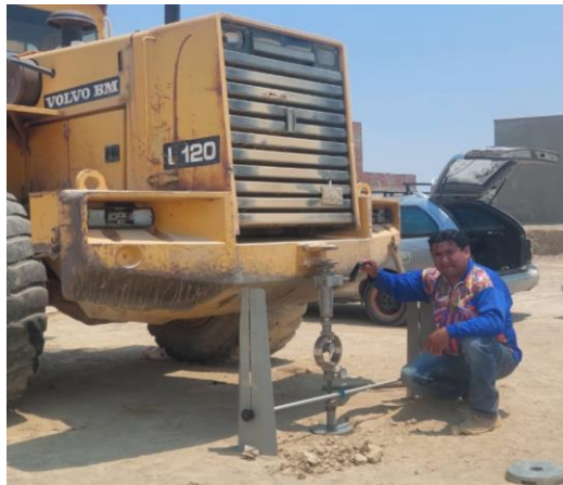
Figura 3.8 Realización del ensayo CBR In Situ
