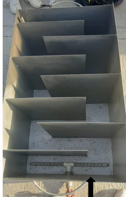
Dispositivo de entrada de agua al biofiltro
