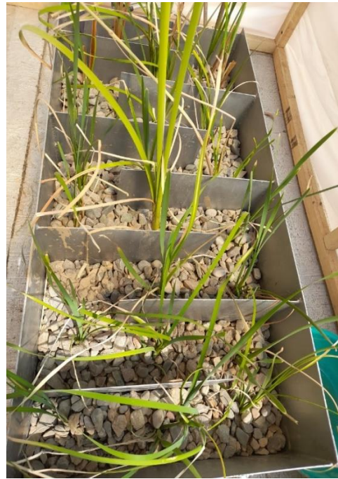
Colocado de capa de grava superior
