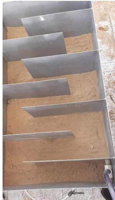
Colocado de la arena
