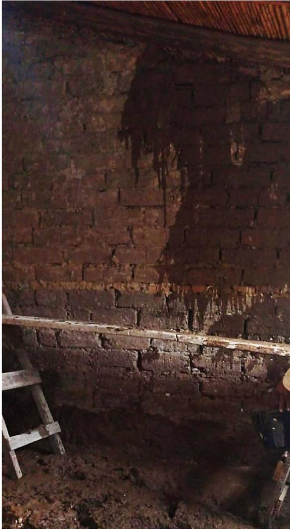
Se quitó todo el revoque, se estabilizó con paja, y se volvió a colocar el mismo revoque, reusando así la tierra y teniendo netamente escombros del retiro del yeso.
