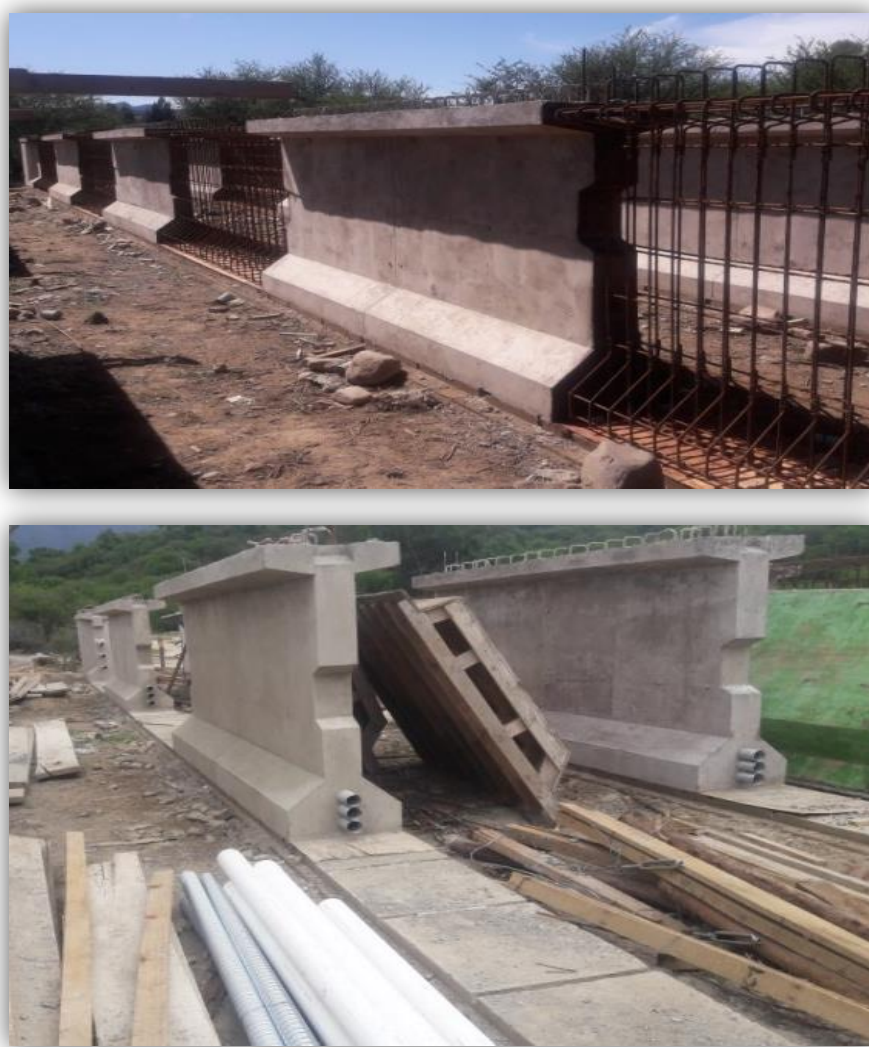
FIGURA N° 4.6 Vigas hormigonadas por Segmento
