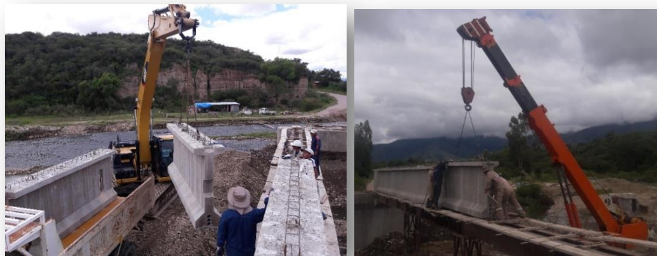
FIGURA N° 4.10 Finalmente Montan los segmentos para Formar la Viga
