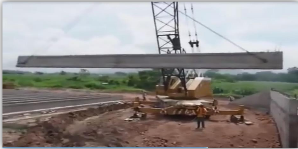
FIGURA N° 4.4 Traslado de viga con grúa, el Espacio libre Importante
