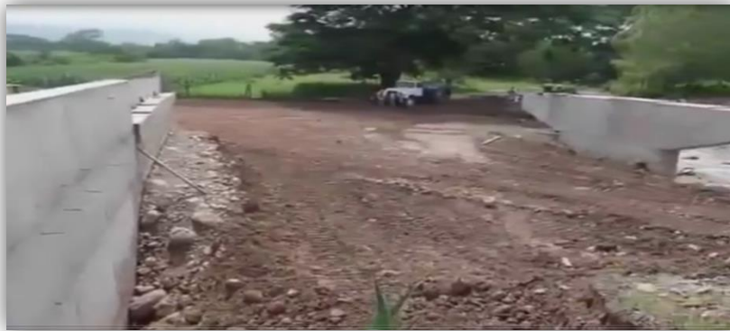
FIGURA N° 4.1 Preparación de Terreno
