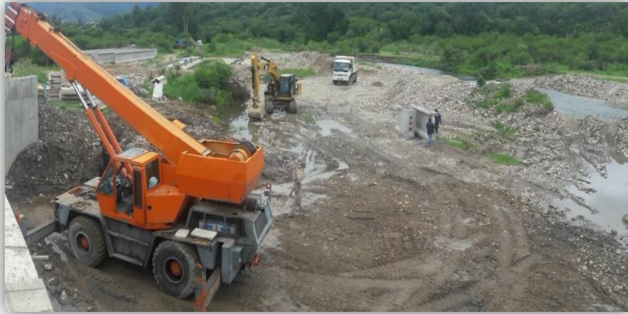
FIGURA N° 4.7 Armado de vigas Montada por Segmento
