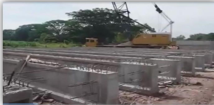
FIGURA N° 4.2 Vigas hormigonadas al pie de Obra
