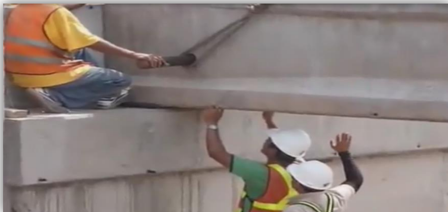
FIGURA N° 4.5 Ubicación exacta de la viga al coronamiento con ayuda del personal existente
