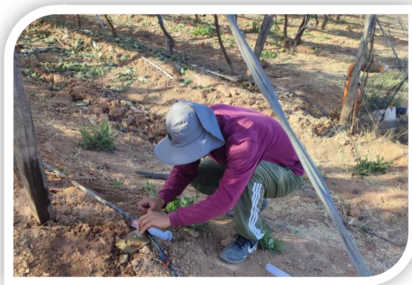
Figura 28: Medición de los caudales y presiones en la subunidad de riego
