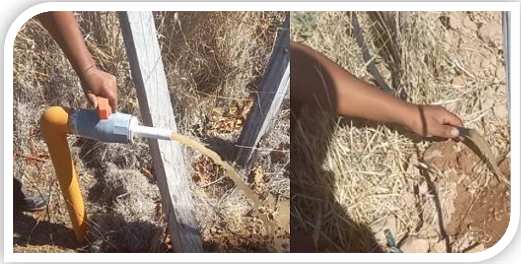
Figura 19: Mantenimiento de tuberías terciaria y laterales
