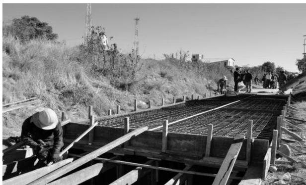
*Figura 9 Construcción del embovedado*
